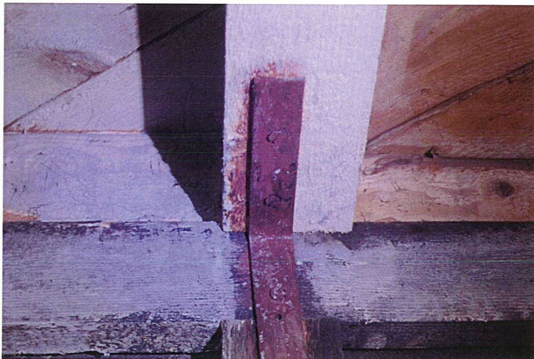
Slika 17: Korozija jeklenih elementov v stiku z obdelanim lesom
