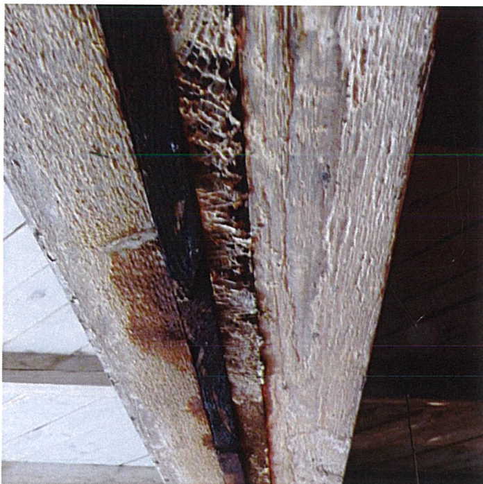
Slika 2: Sestava linearnega nosilca. Pasnica obdaja križno žebljane deske.
