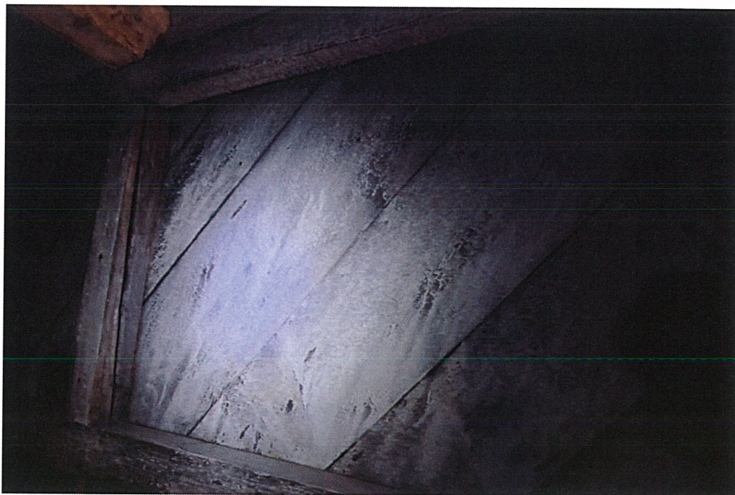
Slika 16: Depoziti v obliki kristalov na površini lesa
